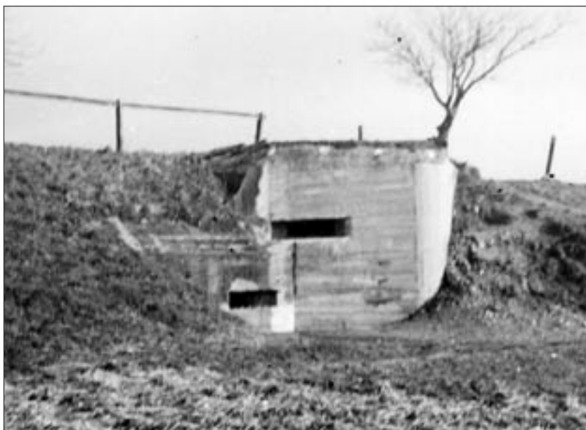
Fotografie objektu B-S 5a „Videň II“. Objekt je zachycen v době po modernizaci střelen pro lafety DZ-7. (Sbírka JUDr. Miroslav Novák)
