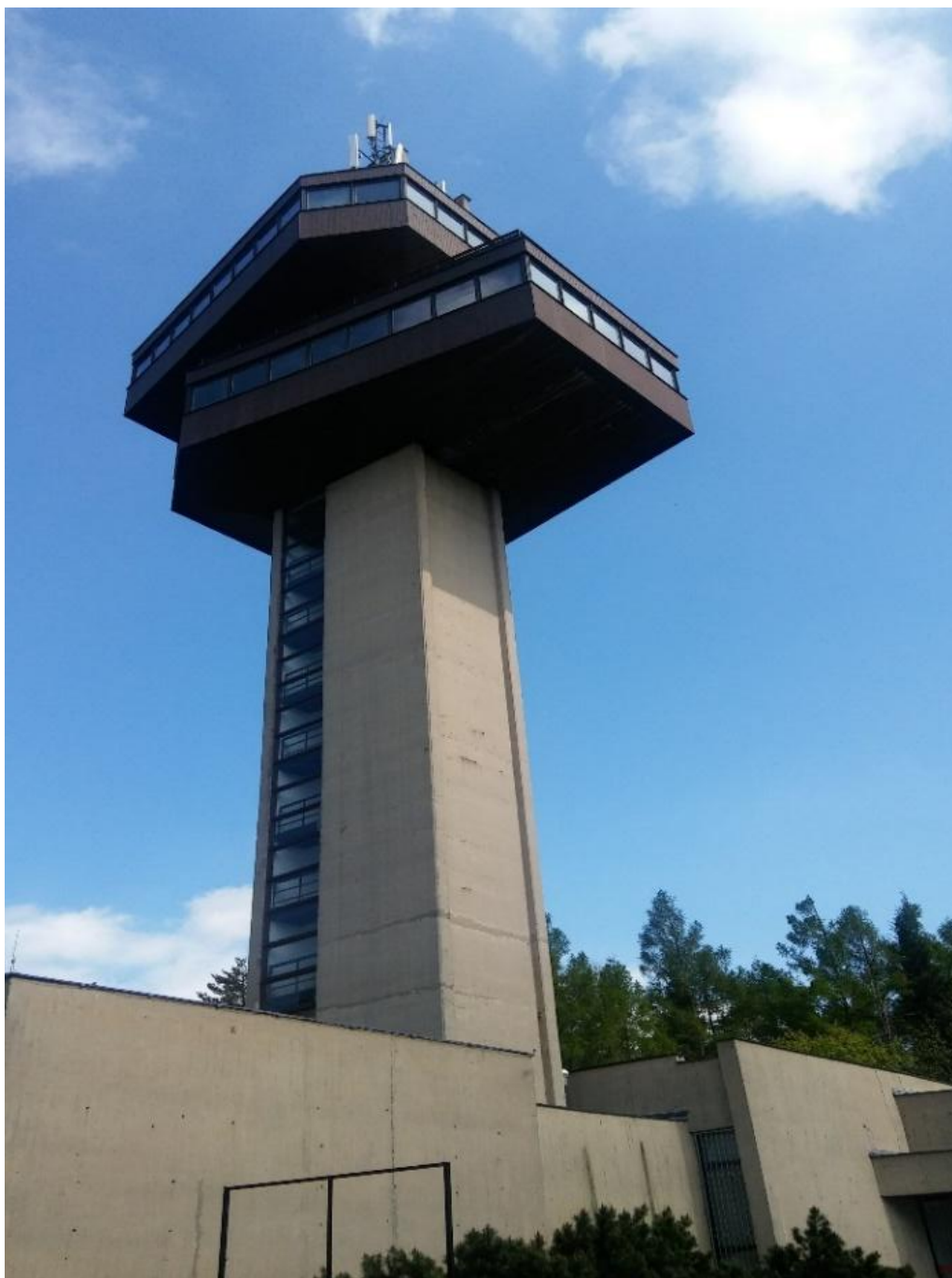
Obr.: Pohľad od vstupu do areálu VVnD
