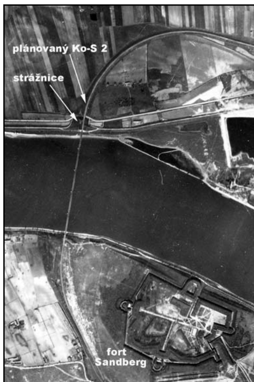
4) Letecký snímek mostu přes Dunaj s vyznačeným blokhausem a fortem Sandberg (dnes Monoštor) v Maďarsku. Letecký snímek pochází pravděpodobně z roku 1936 (VÚA-VHA Praha).
