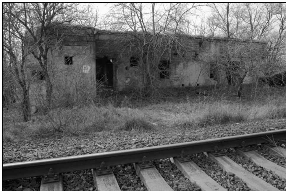
3) Vchodová část strážnice v roce 2006 (foto Radek Hrabčák)
