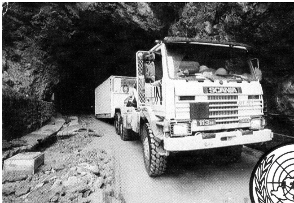
Detailný záber (výrez z pohľadnice) na vjazd do tunela pri obci Vareš. Za povšimnutie stojí fakt, že nákladný automobil vlečie náklad po zemi, čo svedčí o malých rozmeroch tunela.
