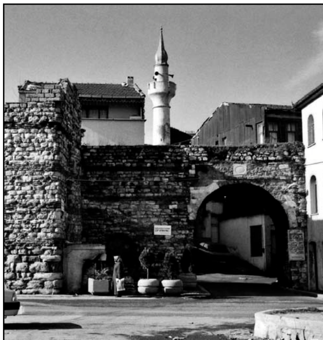
Obr. 5. Cibali Kapı (foto autor)
