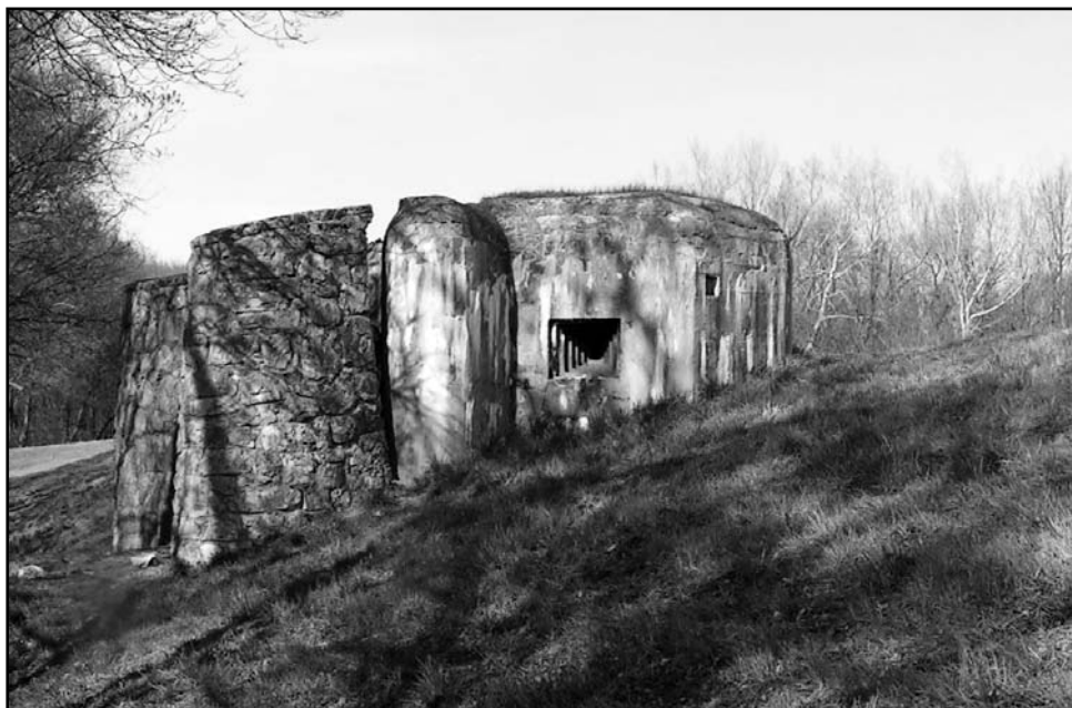
Objekt lehkého opevnění vz. 37 u obce Suchohrady nedaleko Gajar postavený do protizáplavové hráze na břehu řeky Moravy (Jan Lakosil)
