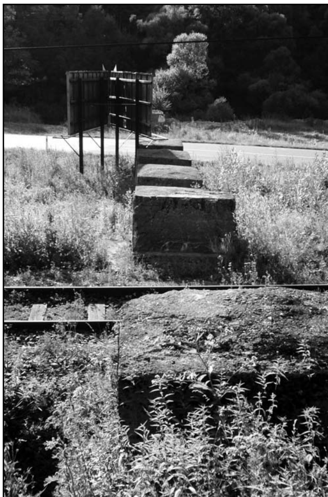
Obr. 5. Přehrazení údolí řadou bloků (Porúbka, foto I. Vondrovský, 2007)
